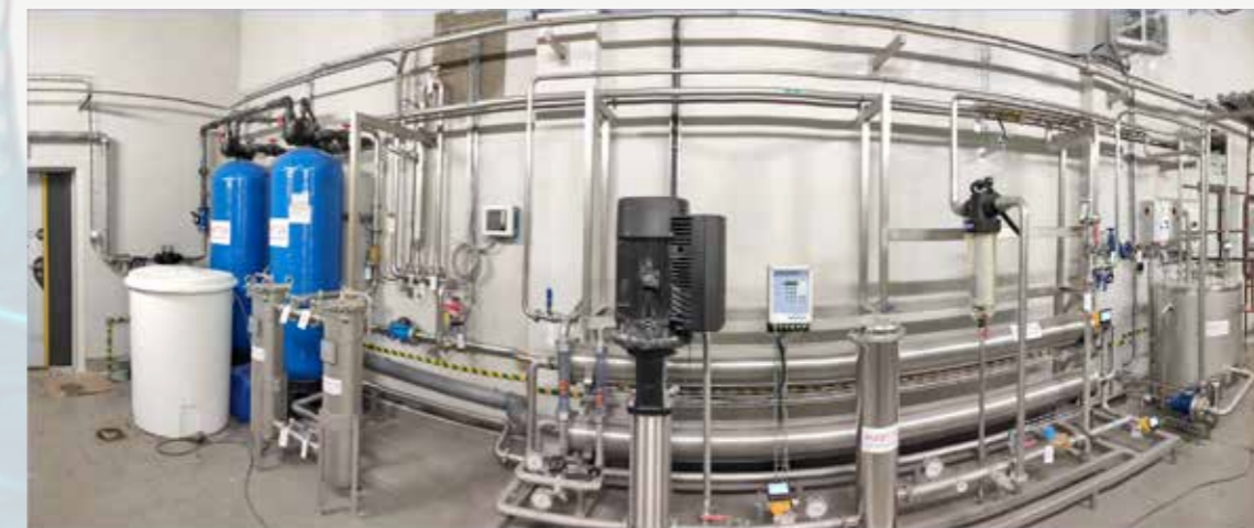
Fot. 2 Stacja RO przygotowania wody zdemineralizowanej dla celów zasilania kotłowni pracującej w układzie kogeneracji
