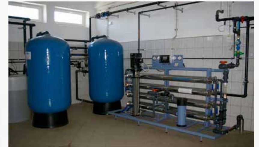
Fot. 1 Instalacja RO dla celów kotłowych. Woda jest wstępnie uzdatniana w filtrze węglowym, a następnie zmiękczaczu
